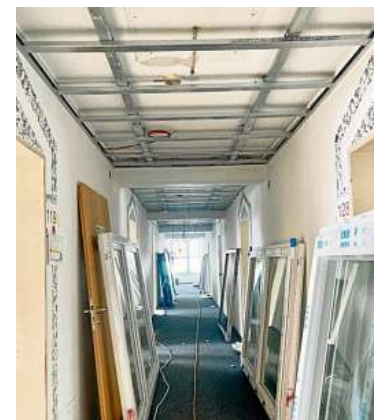
Alle Flure bekommen neue Deckenkonstruktionen für Daten- und Elektrokabel.
