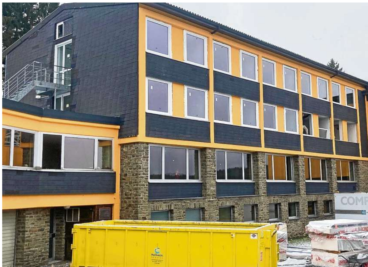
Das Gesundheitscamp Kirchhundem in Rahrbach wächst. Das Gebäude hat mittlerweile einen neuen Anstrich bekommen. Im Frühjahr soll alles fertig sein.
